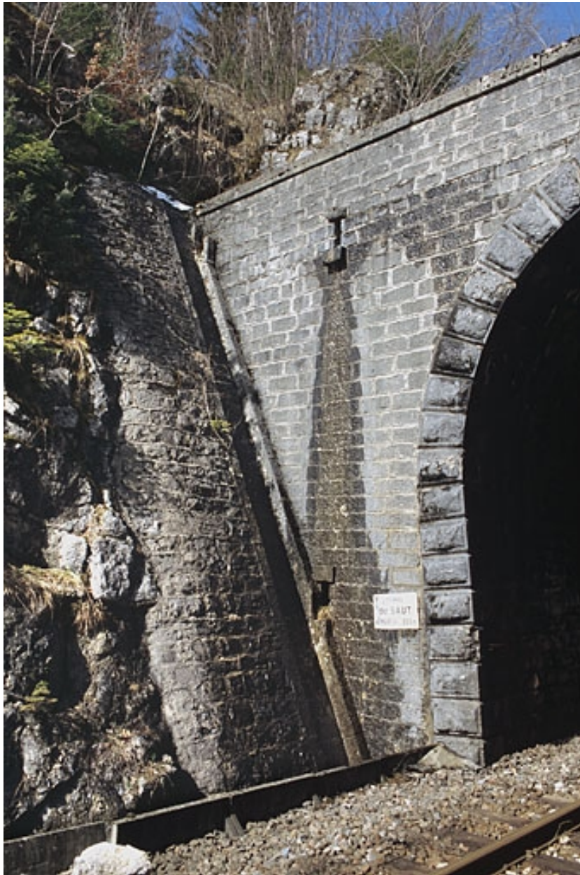
Tête côté La Cluse : descente d'eau, chantepleurs et caniveau.
