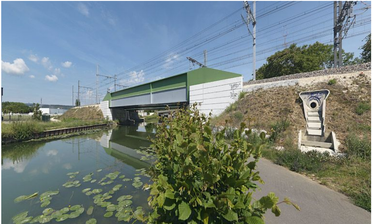
Vue d'ensemble d'aval.
