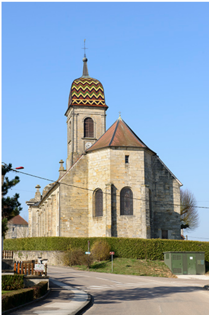
L'église, vue depuis l'Est.
