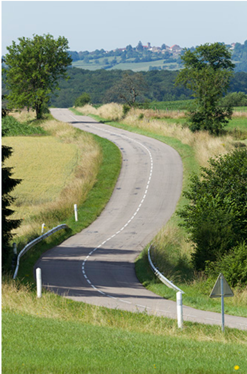
La route départementale 434.
