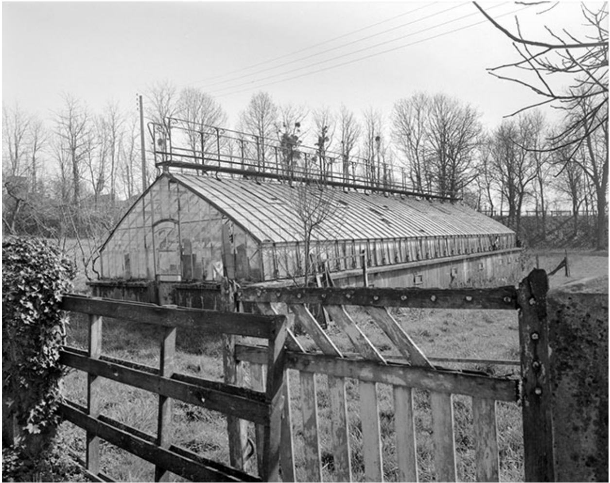
Vue d'ensemble de la serre.
