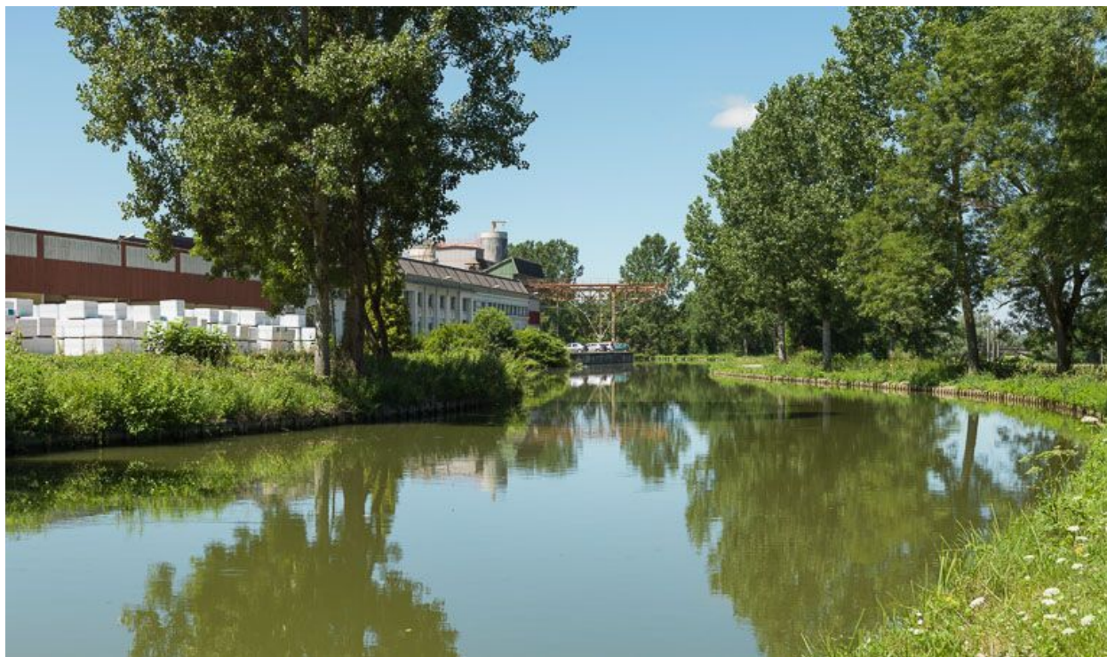
Vue d'ensemble de l'usine, rive gauche.
