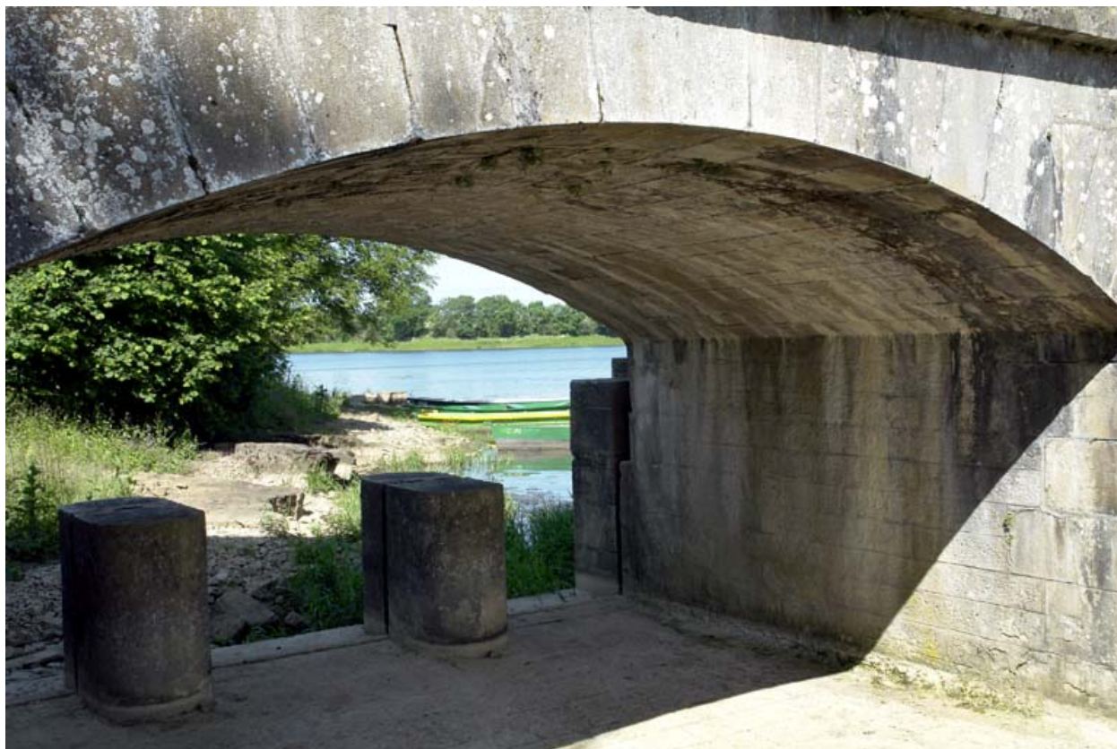
Déversoir de superficie.
