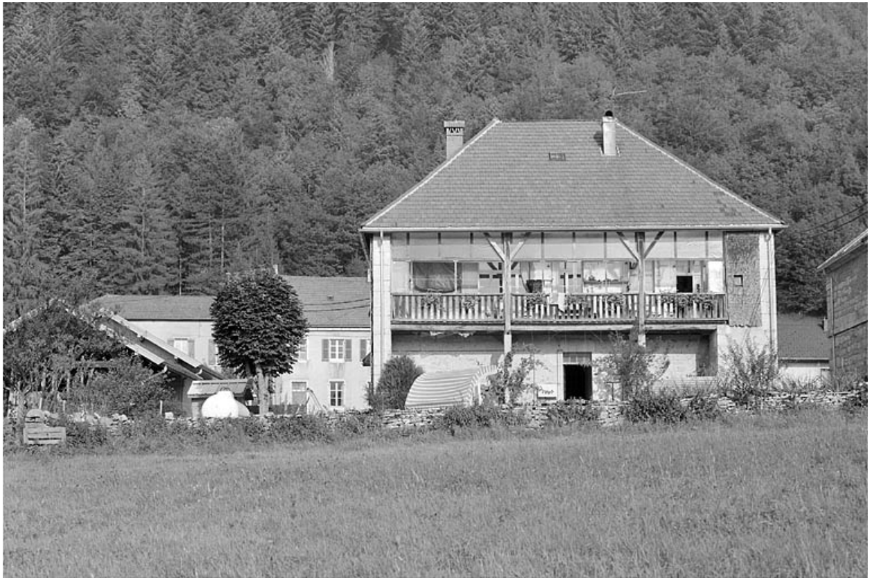
Vue générale de la façade postérieure.
