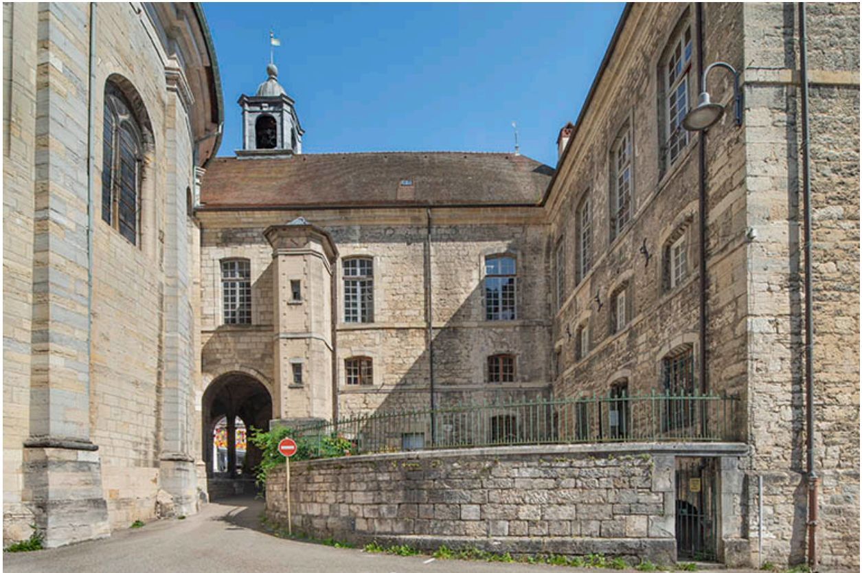
Façade ouest de la partie sud, avec la cour.
