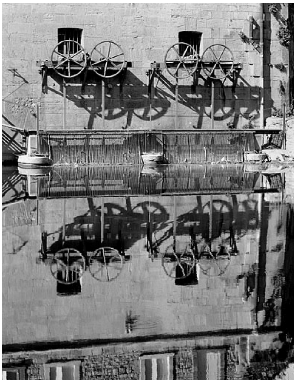
Vannes de prise d'eau à l'amont.
