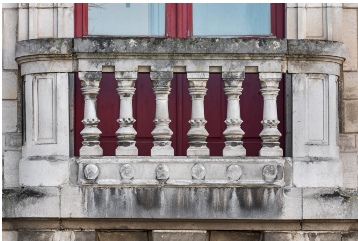
Façade latérale gauche : garde-corps du balcon.
