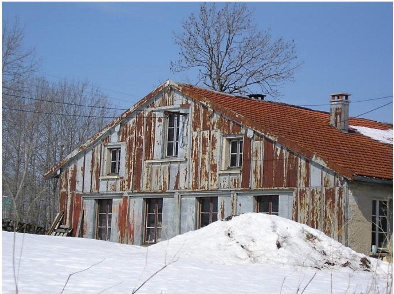
Vue du pignon sud-ouest.
