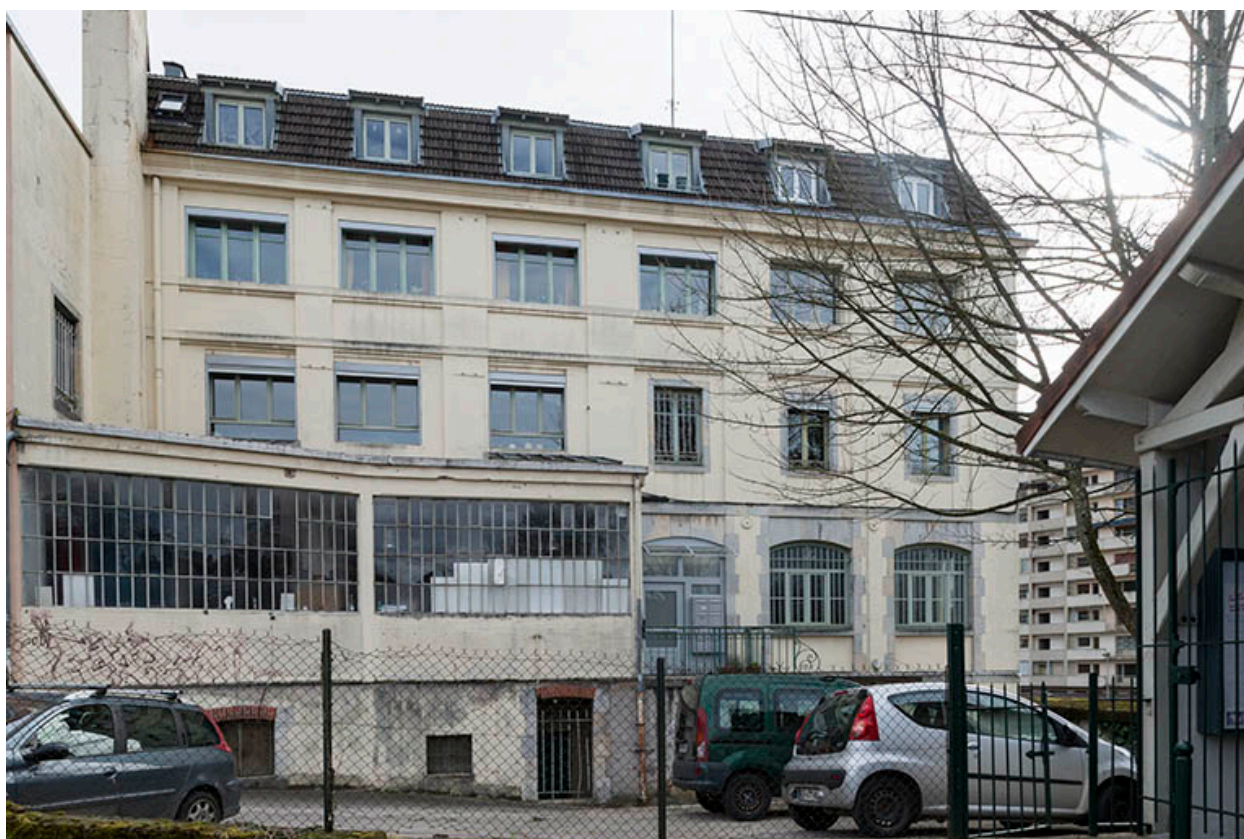
Façade nord de l'atelier principal.
