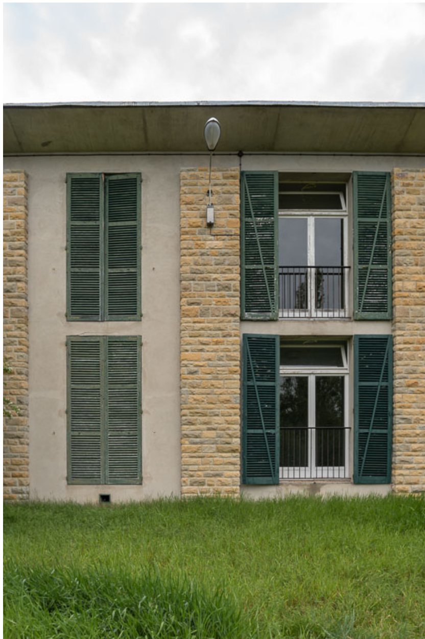
Élévation extérieure de l'aile Bellevue, côté sud, détail de deux travées.
