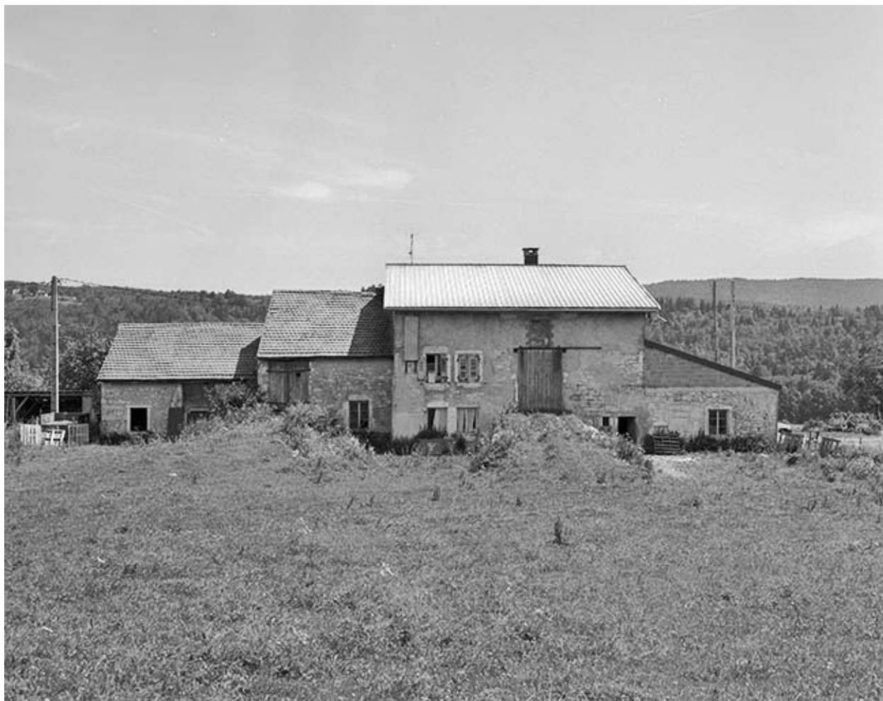
Vue éloignée de la façade postérieure.
