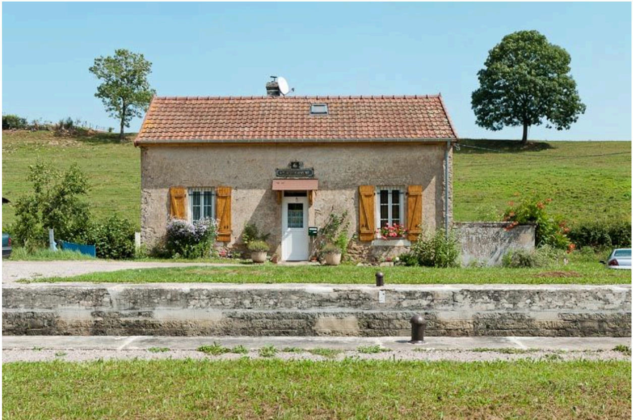
Vue de face de la maison éclusière.
