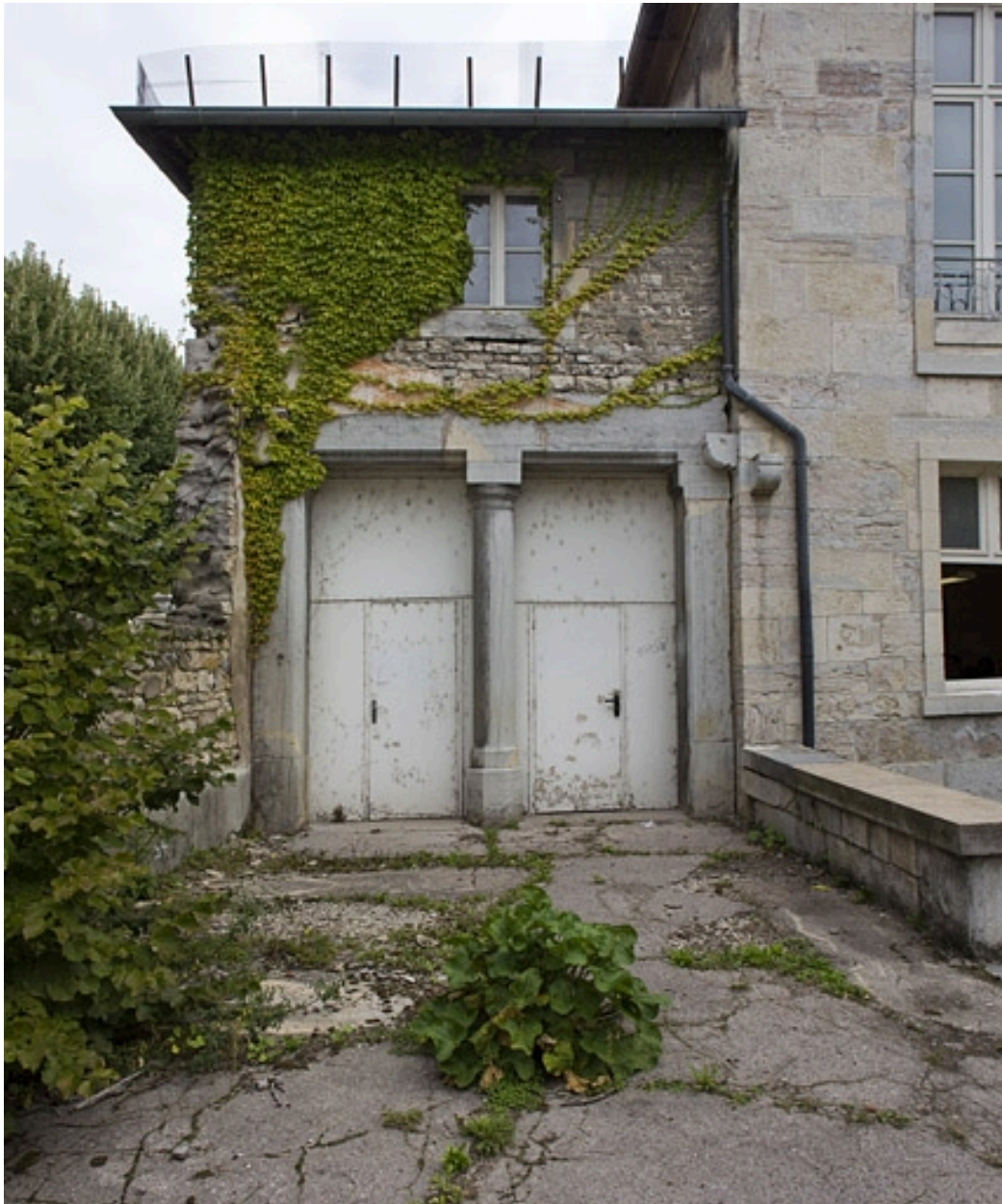
Détail de l'édicule à gauche de la façade donnant sur l'ancien jardin, de face.
