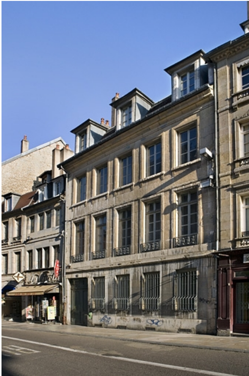
Vue d'ensemble du logis principal sur rue.
