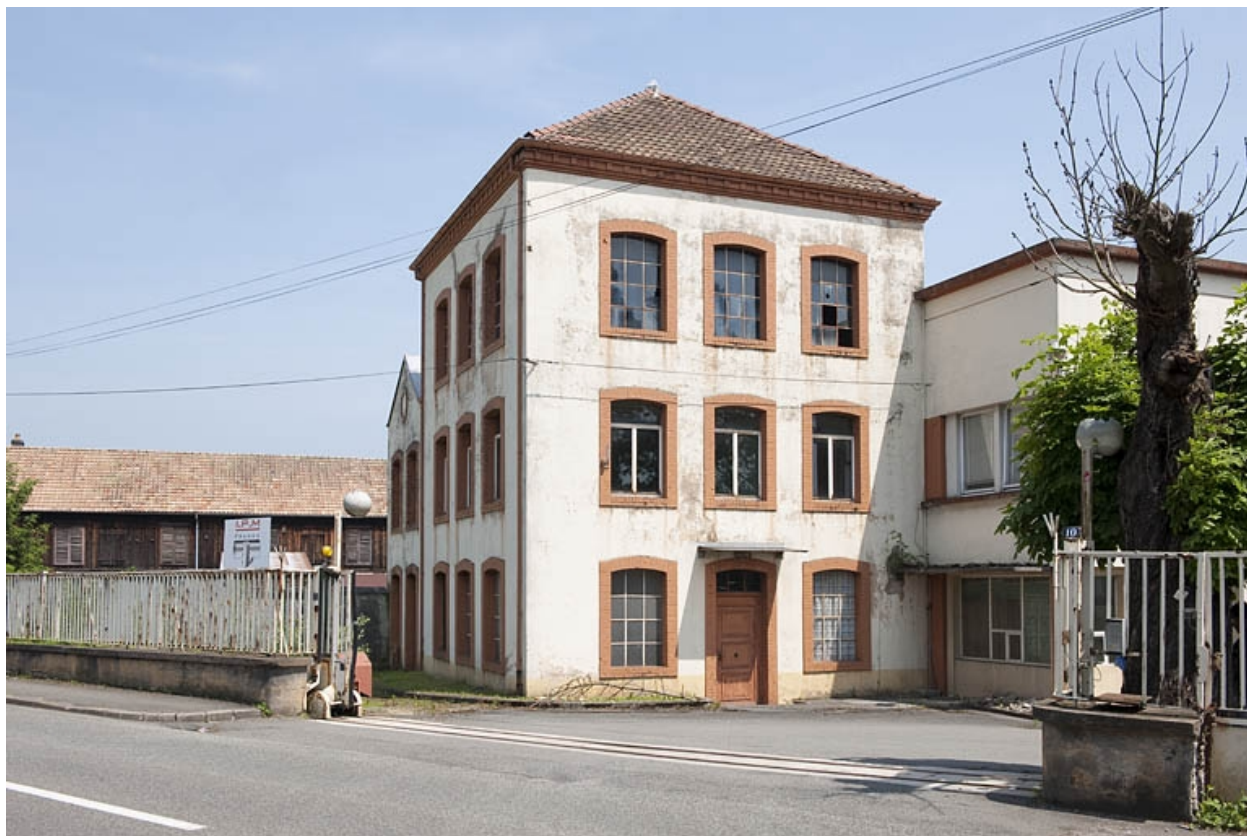
Bâtiment d'entrée vu de trois quarts.
