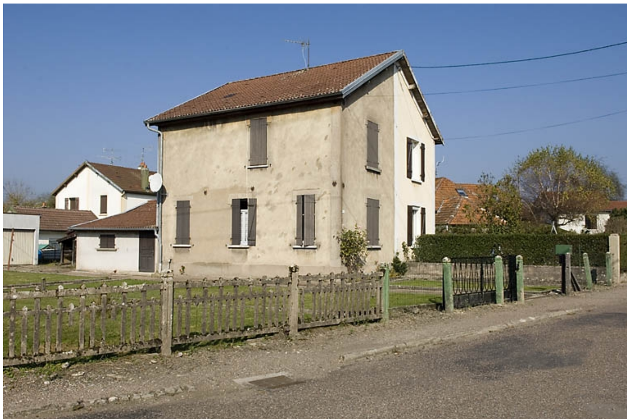
Maison double à étage (rue Jean Jaurès).
