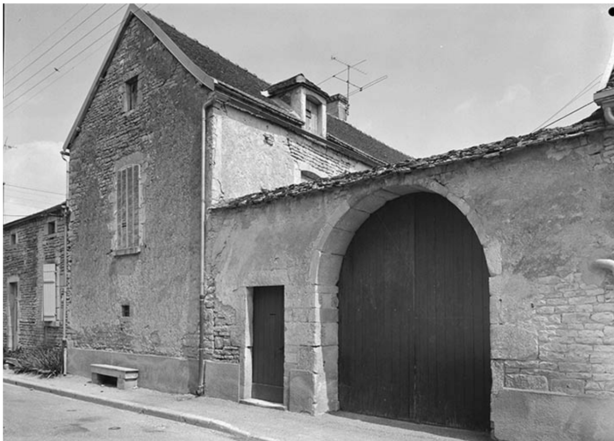
Mur-pignon et portail sur rue.
