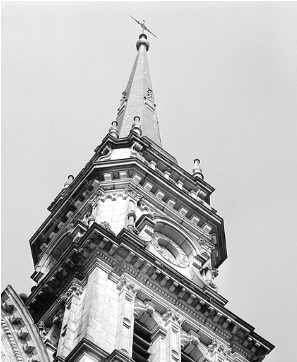
Derniers niveaux de la tour nord vus d'en dessous.
