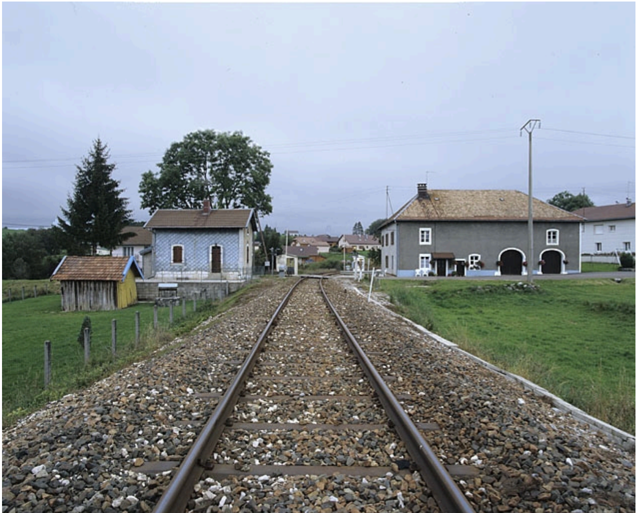
Vue d'ensemble depuis la voie, au sud.
