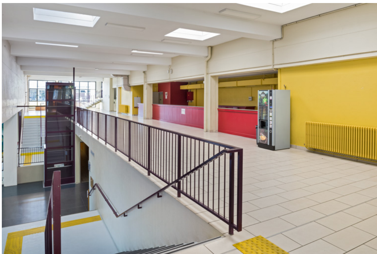
Maison des sports : couloir desservant le bar et les gradins, au 1er étage, depuis le côté RN.
