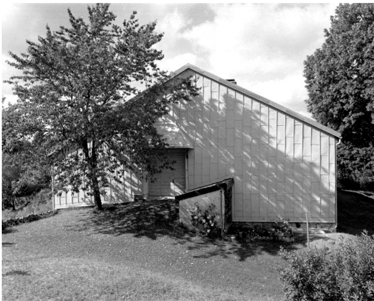
La Pesse, ferme située au lieu-dit Sur les Couronnes : facade gauche recouverte d'un essentage de zinc.
