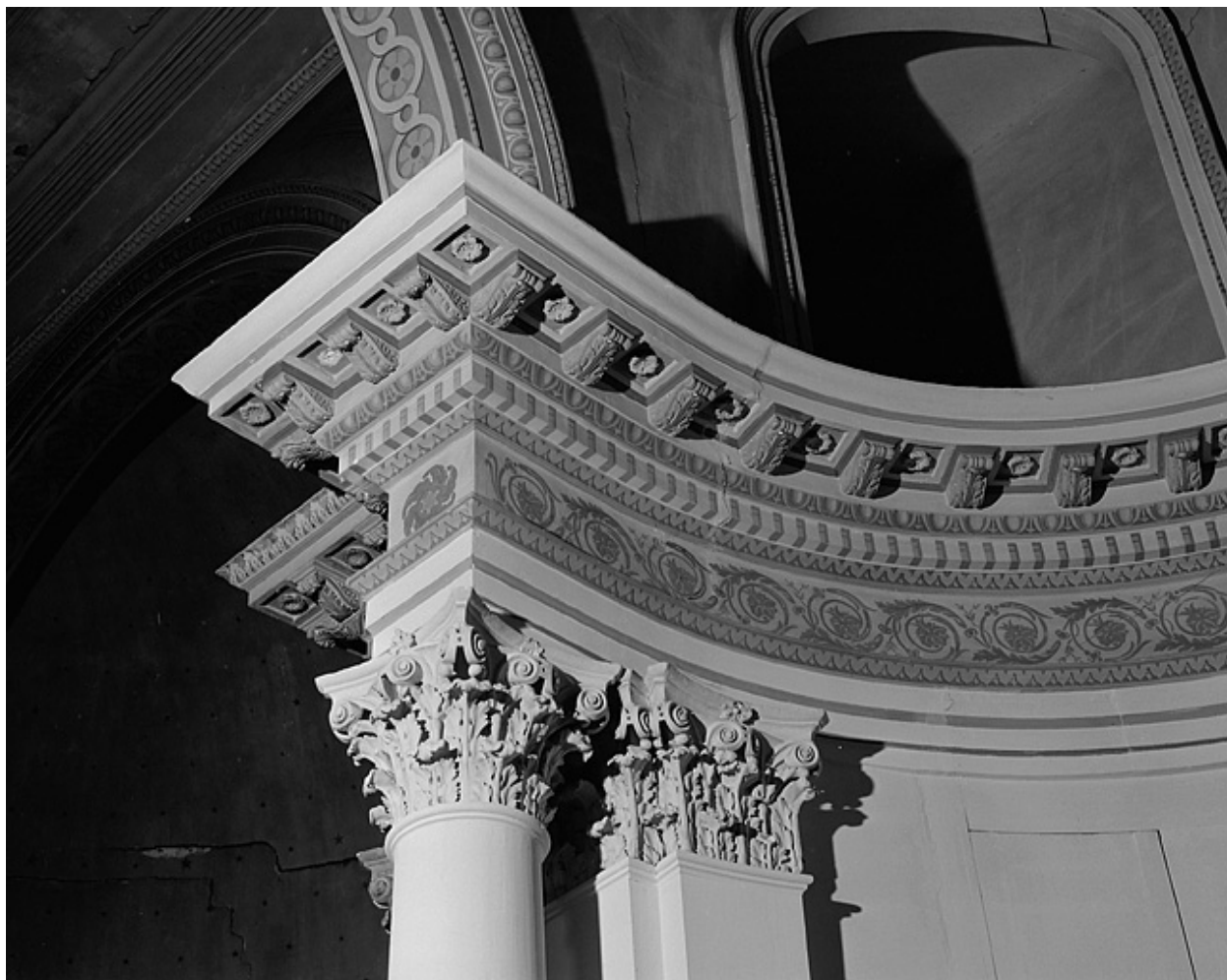
Chapelle II, détail de l'entablement du vaisseau.
