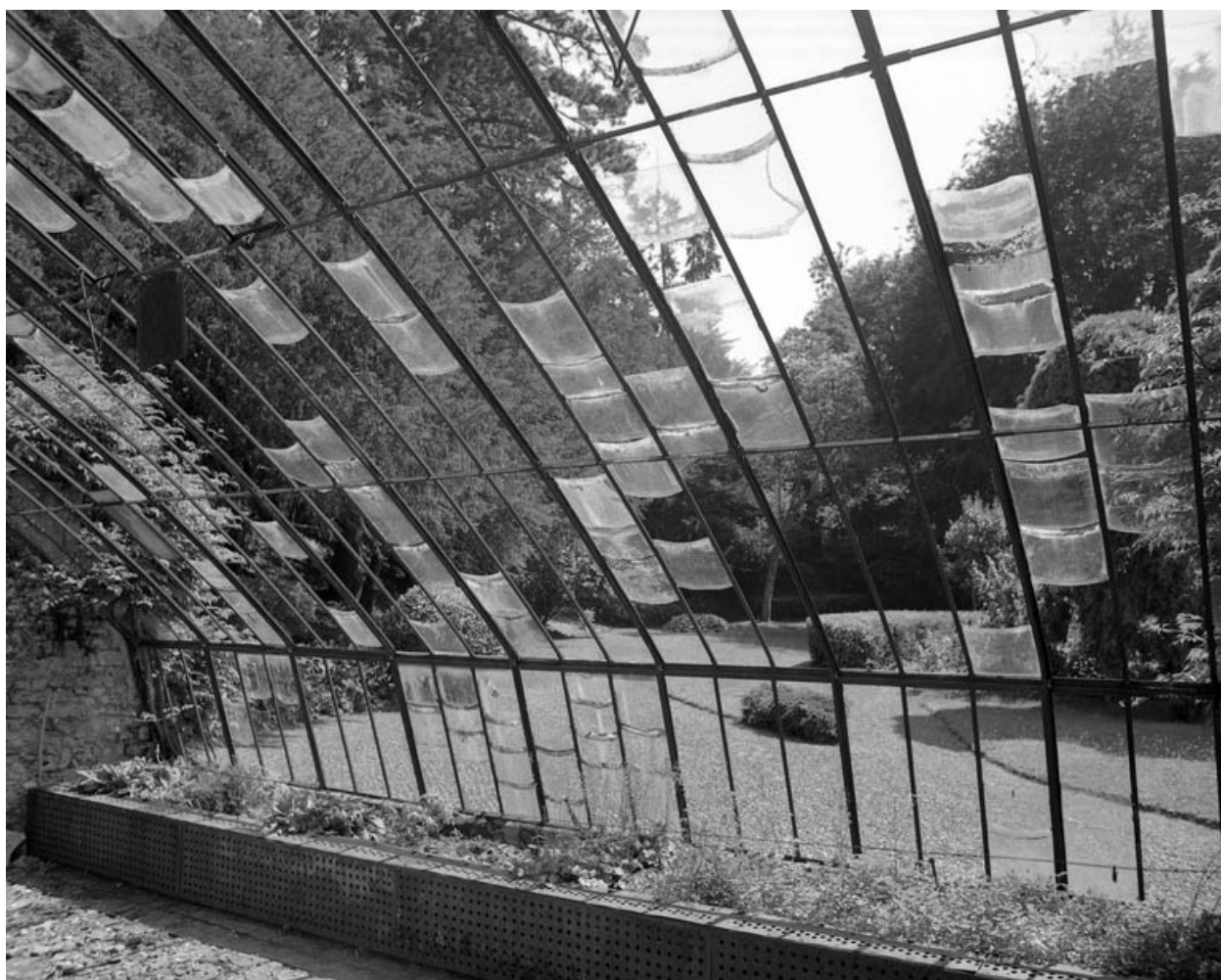
Serre : détail de la verrière.
