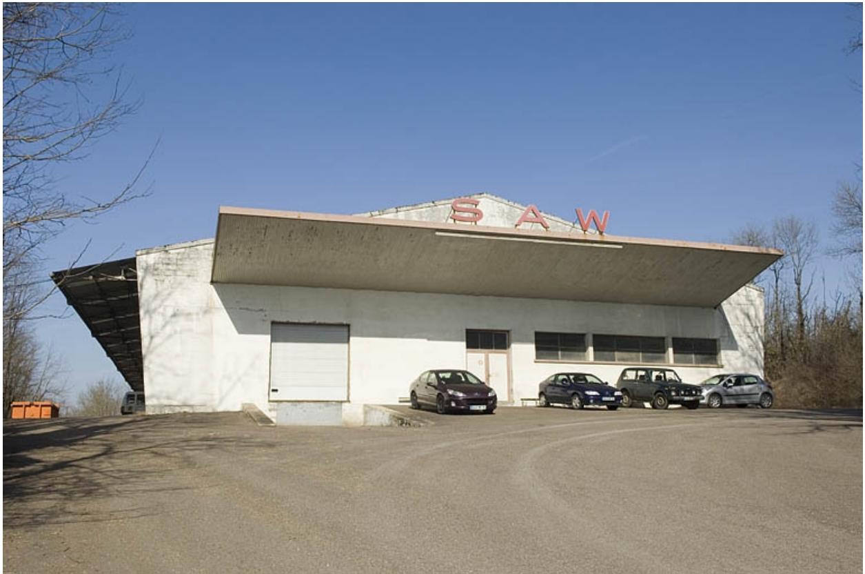
Mur-pignon de l'atelier de fabrication (rondelles).
