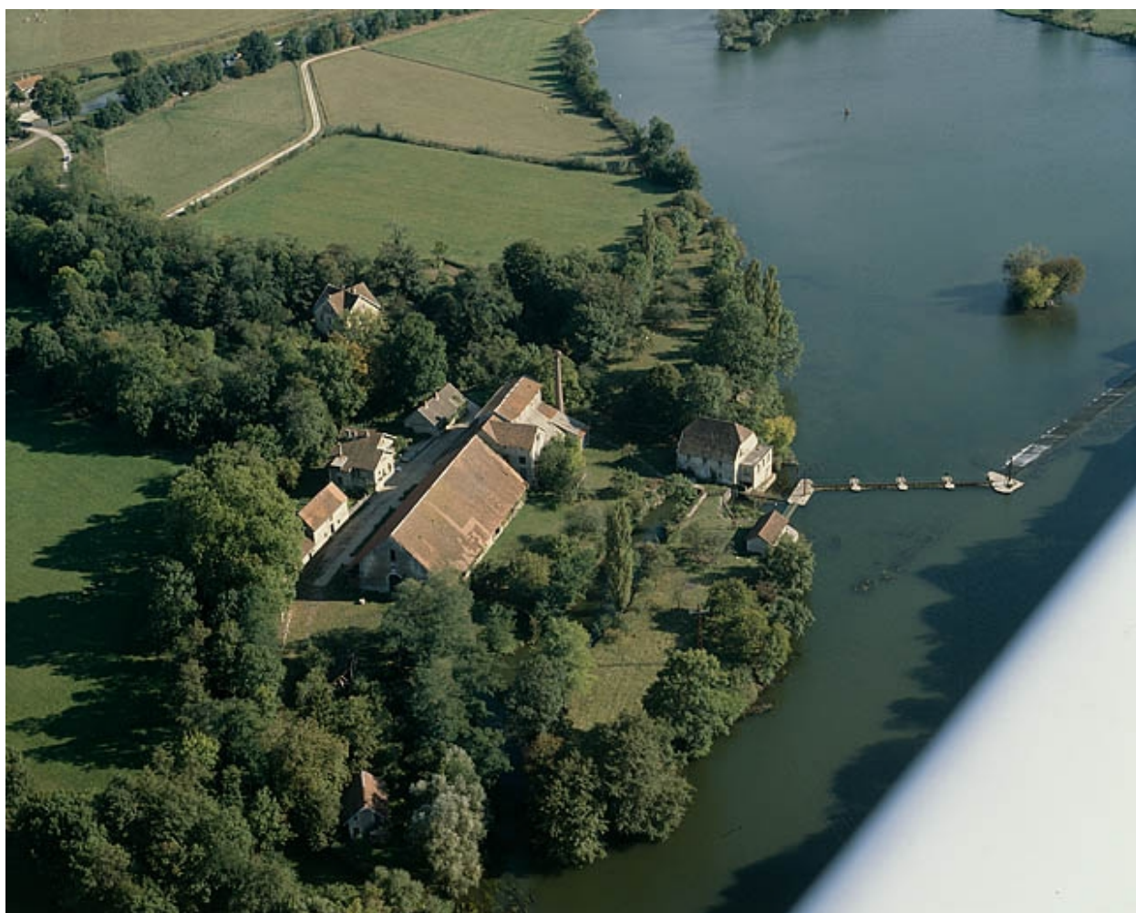
Vue aérienne plongeante depuis le nord en 1989.
