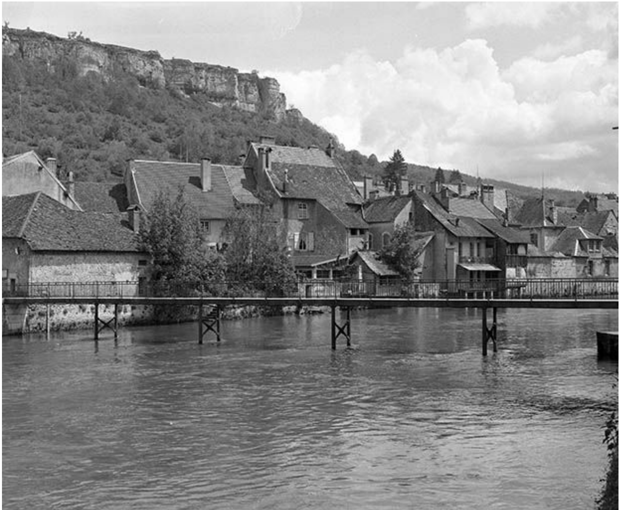
Façades postérieures des maisons de la rue Pierre-Vernier en aval de la passerelle.
