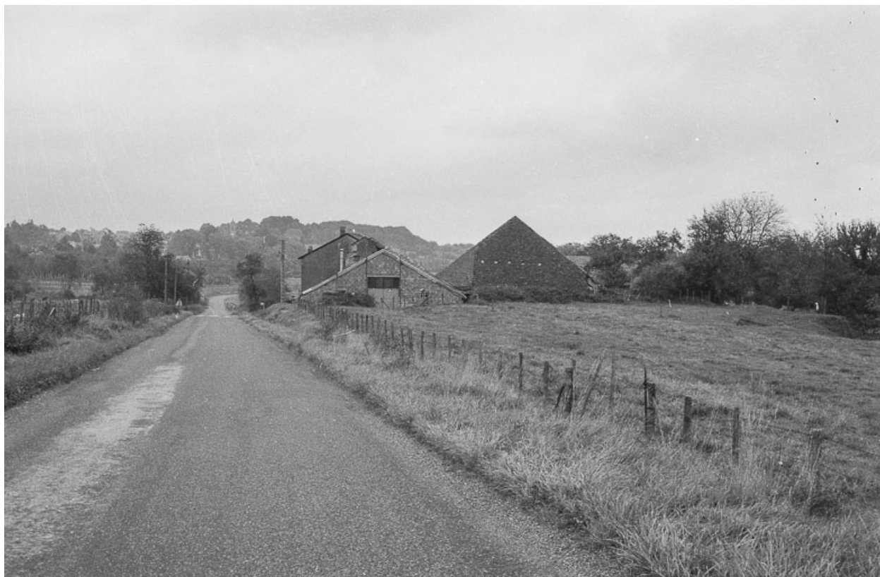
Vue d'ensemble depuis la route.
