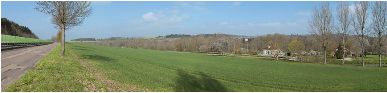
La traversée de Fleurey-sur-Ouche par le canal : vue sur le viaduc ferroviaire de Fain.
