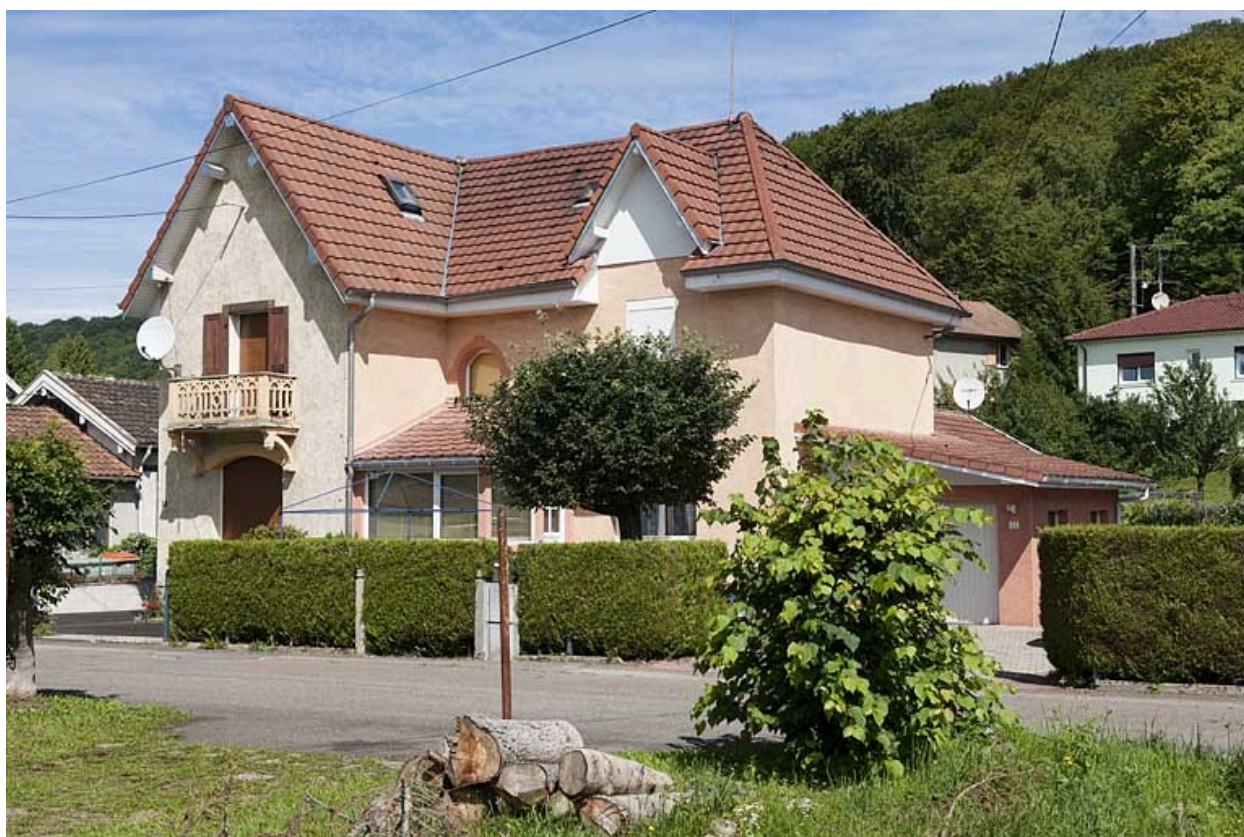
Maison de contremaîtres (n°12-14).
