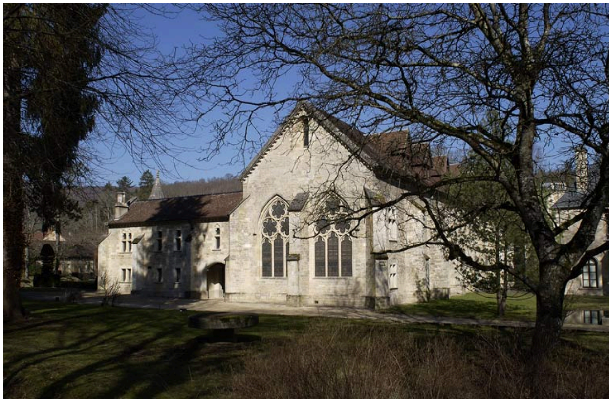
Bâtiment du réfectoire : élévation sud.
