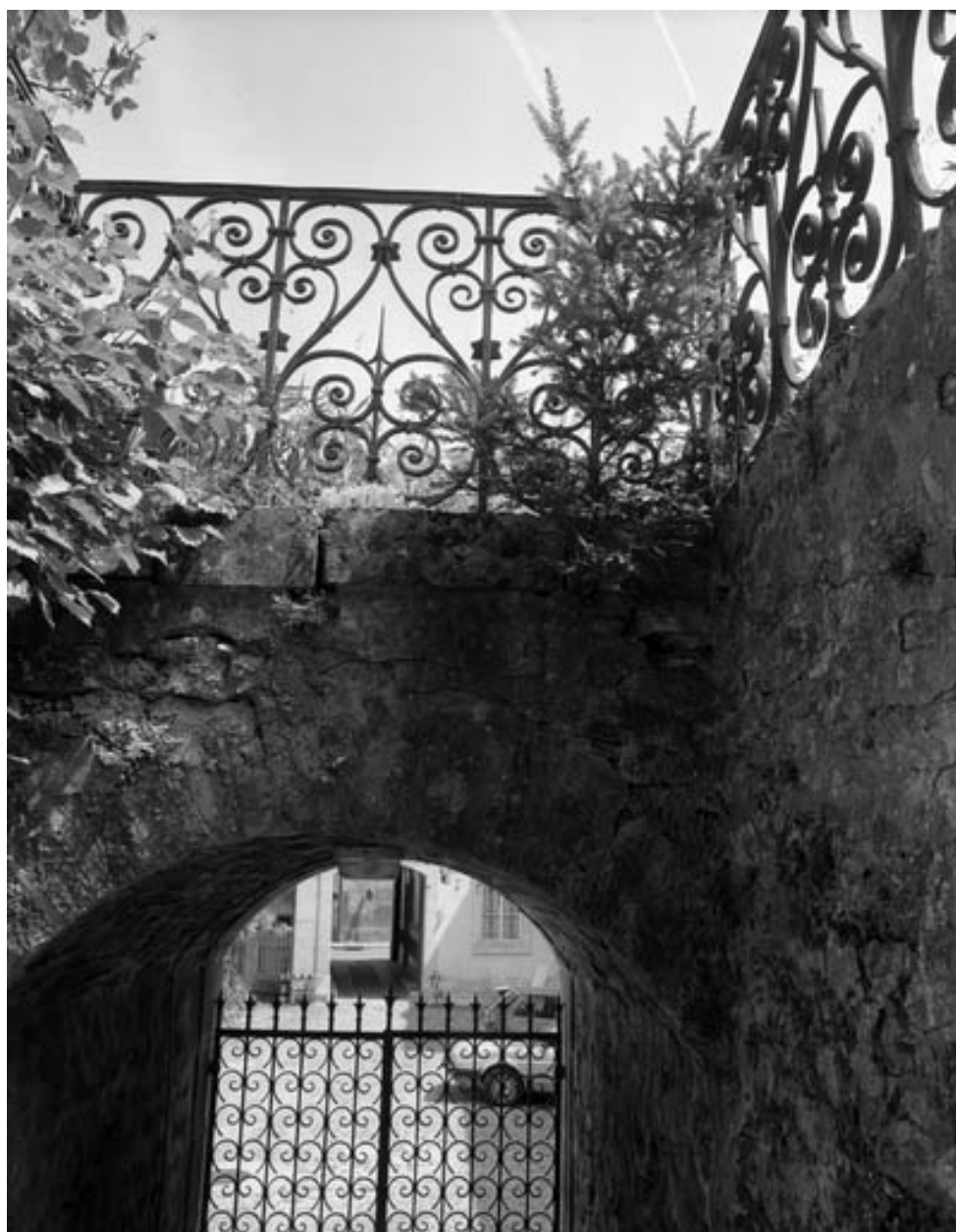
Détail du parapet de l'escalier du jardin.
