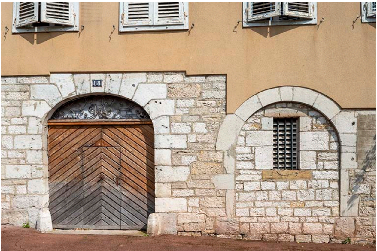
Ouvertures sud de la façade antérieure.
