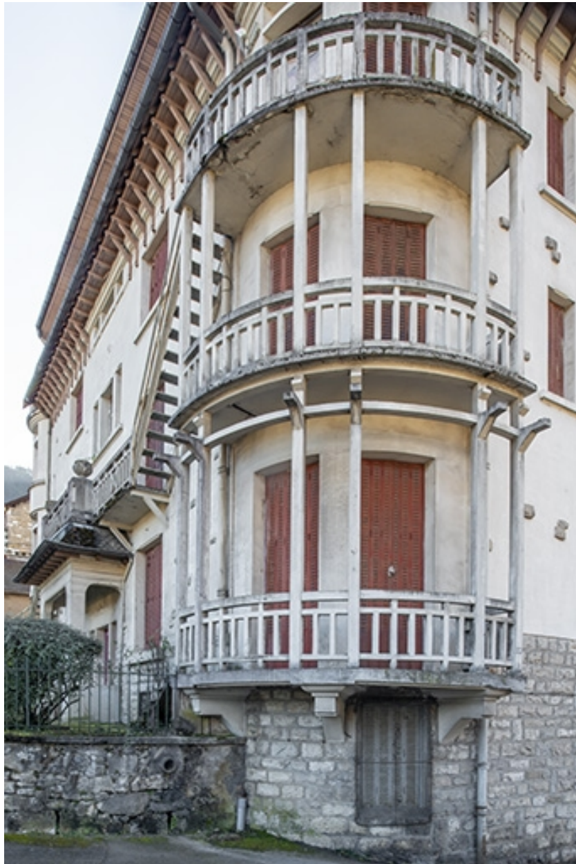
Balcons de l'angle nord-ouest.
