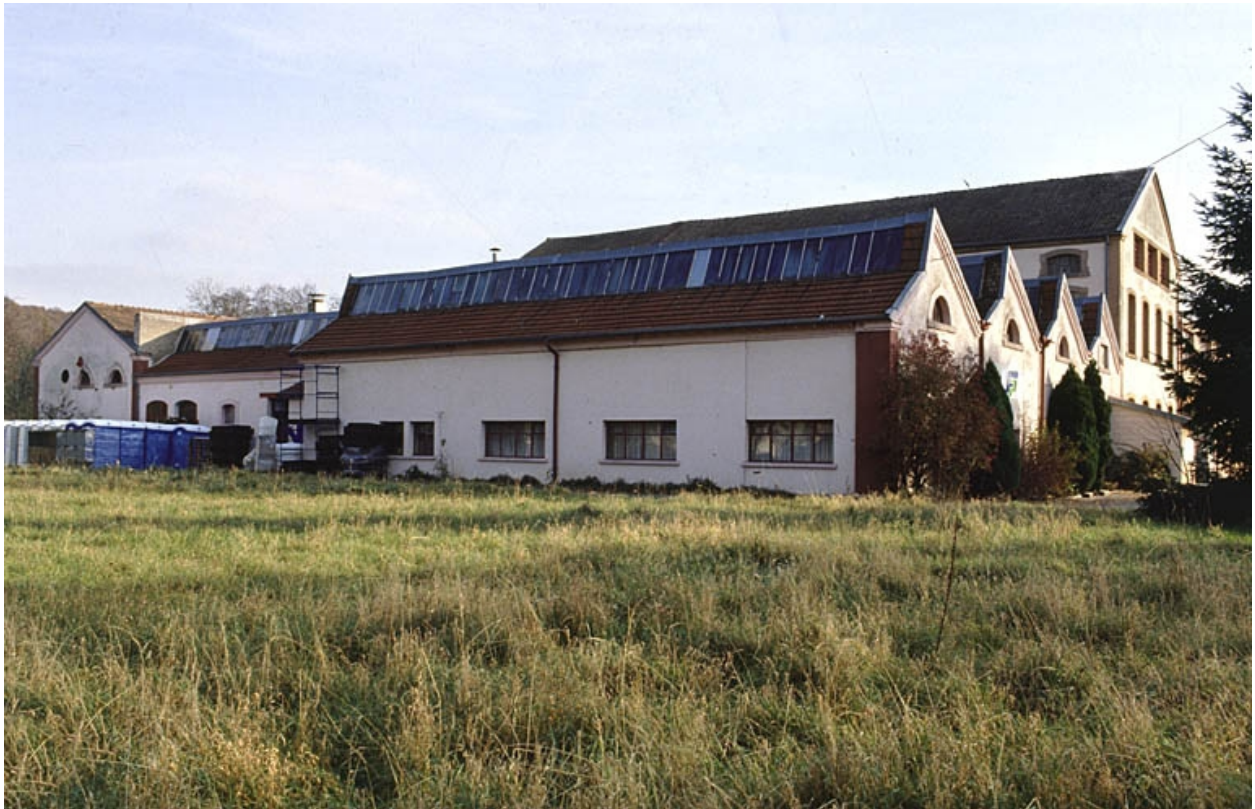
Vue de trois quarts depuis l'ouest.
