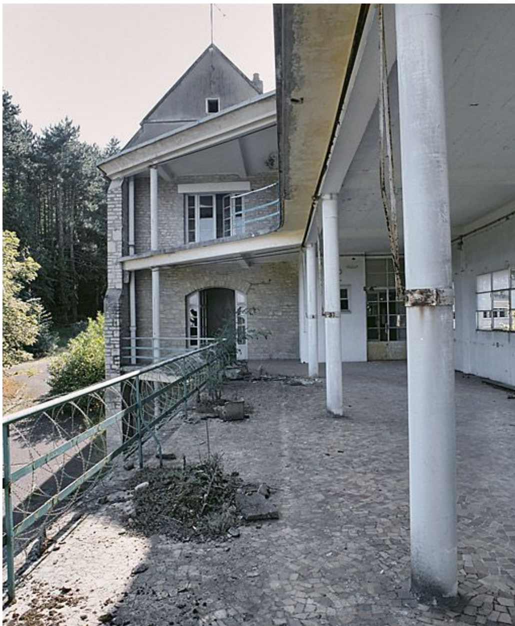
Galerie de cure est, façade sud-est.
