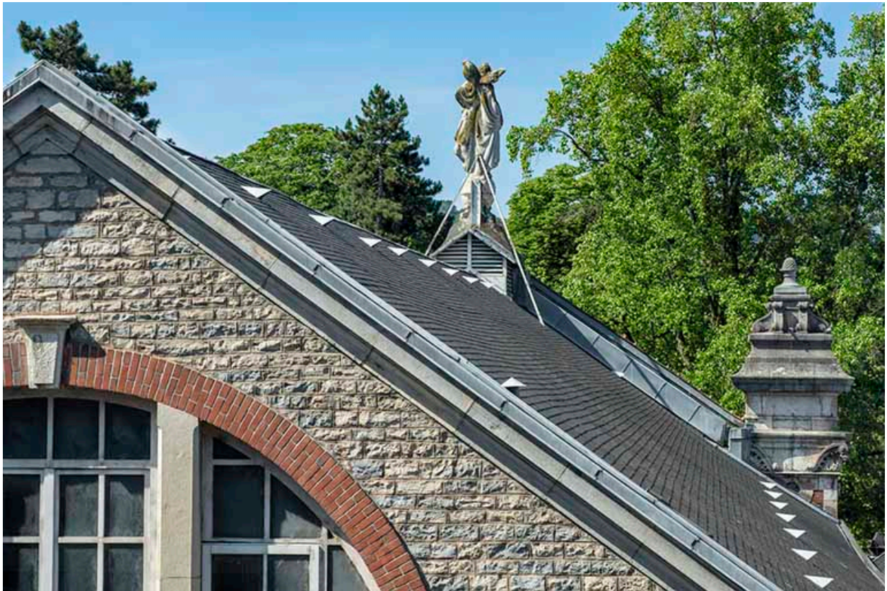
Toiture, vue depuis le nord.
