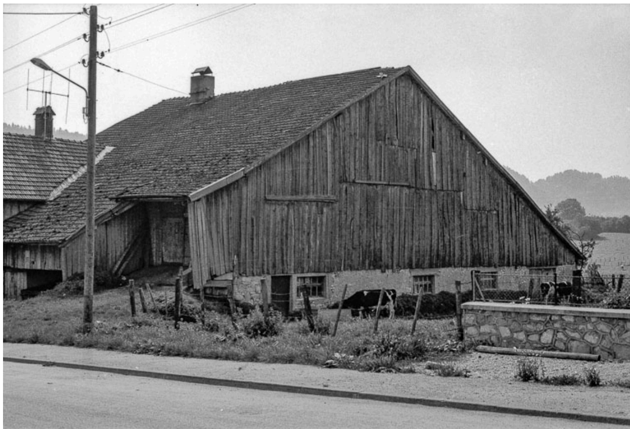
Ferme : façade latérale droite.
