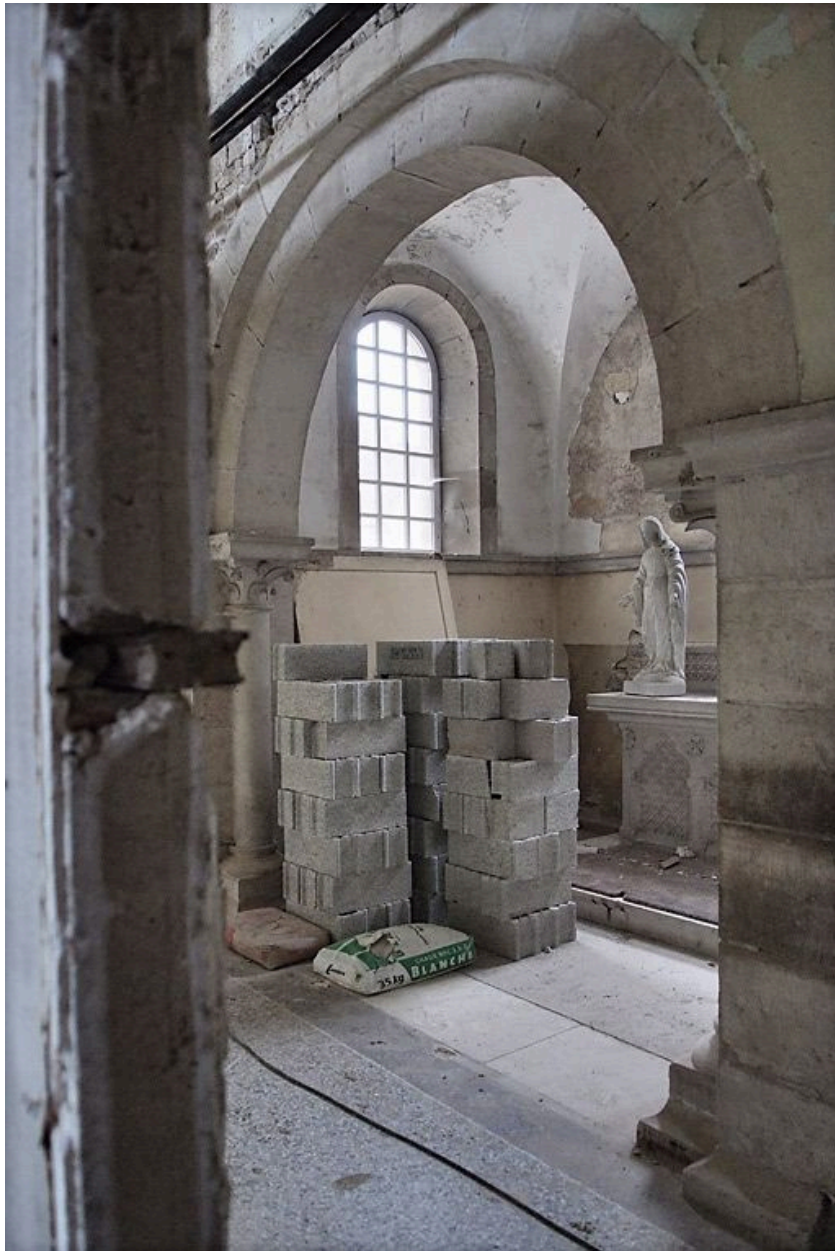
La chapelle pendant les travaux.
