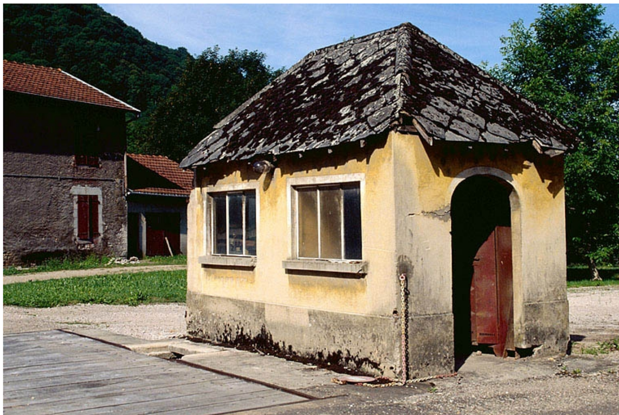
Poste du pont bascule.
