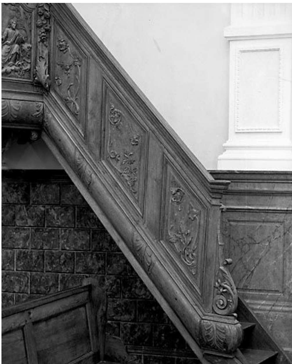
Détail : la rampe.
