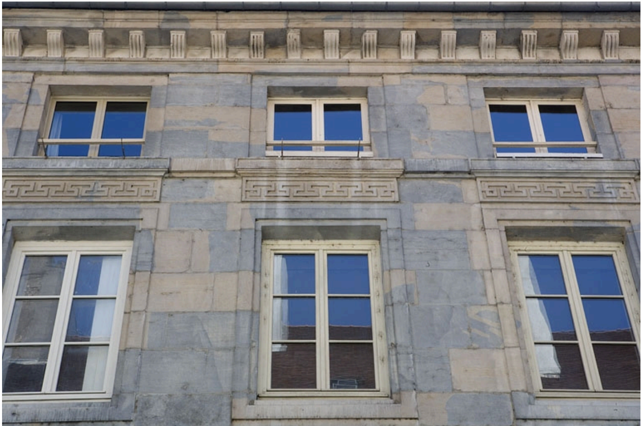
Détail des fenêtres des deuxième et troisième étages.
