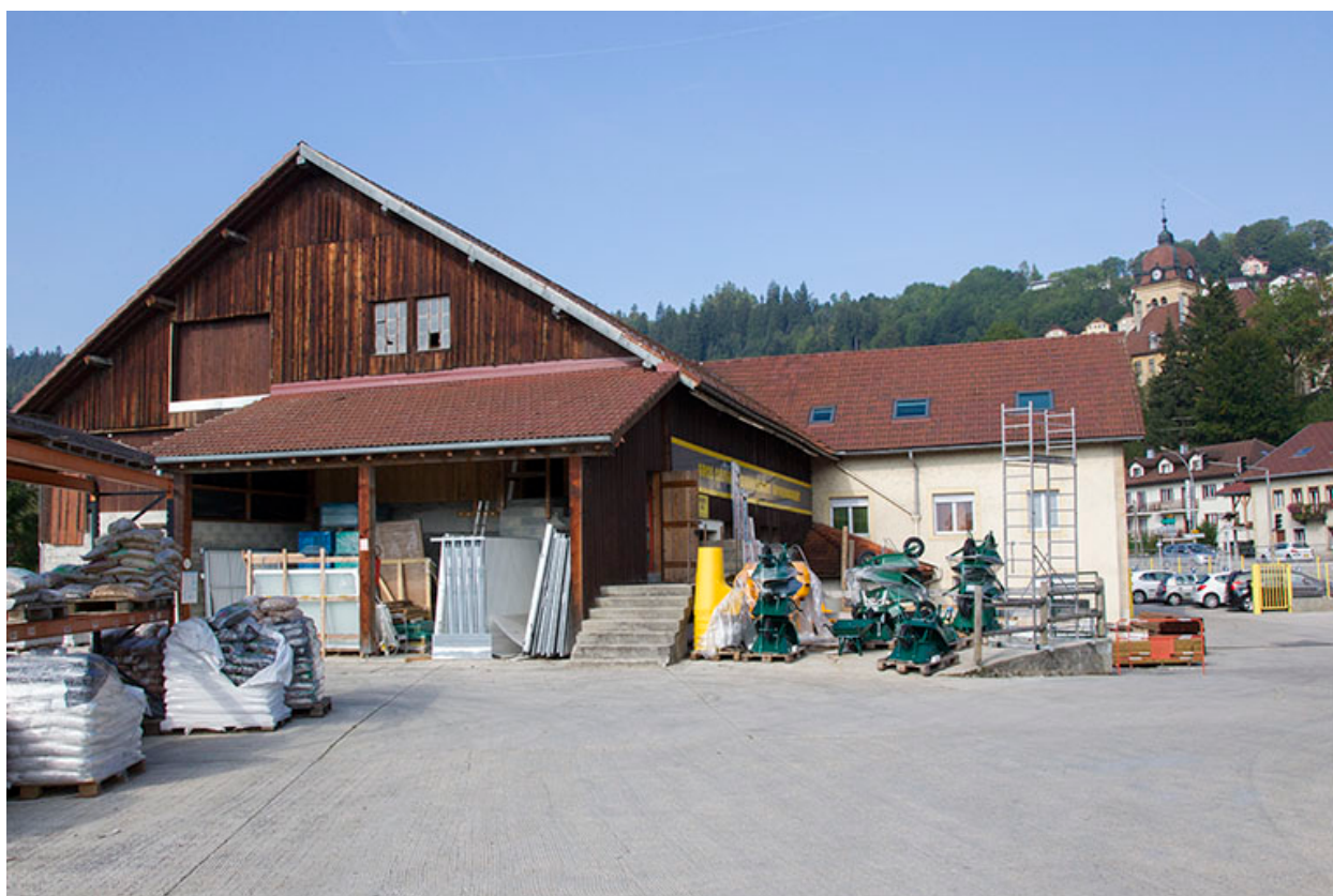
Bâtiments, vus de l'est.
