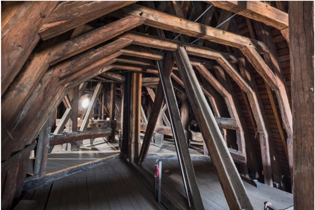
Comble : vue prise depuis le chevet oriental.
