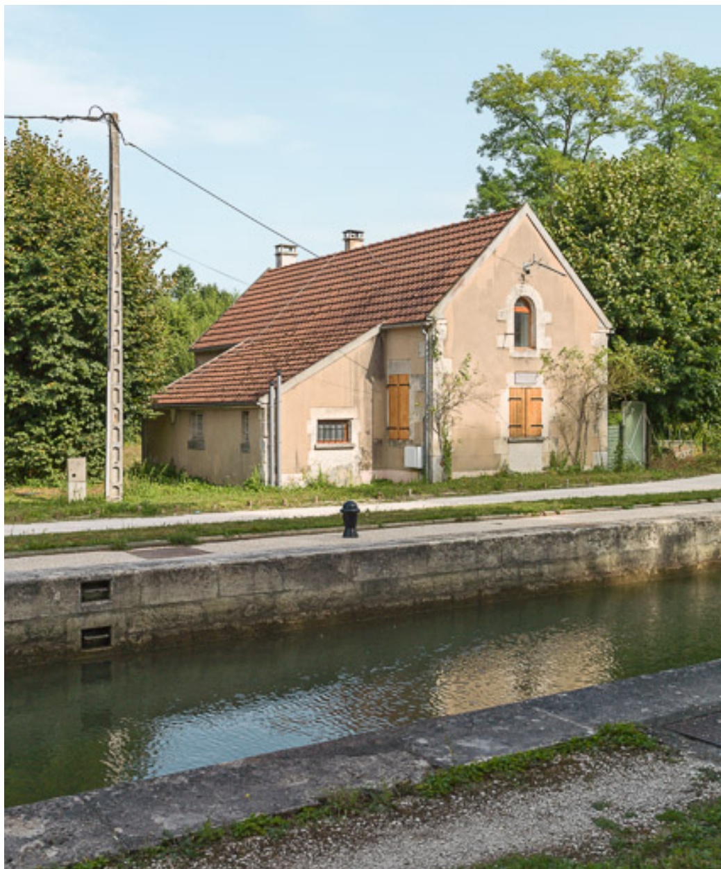
Vue de la maison éclusière.
