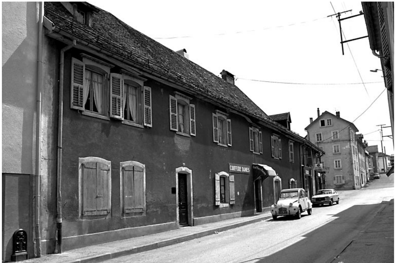
Façade sur rue de trois quarts gauche.
