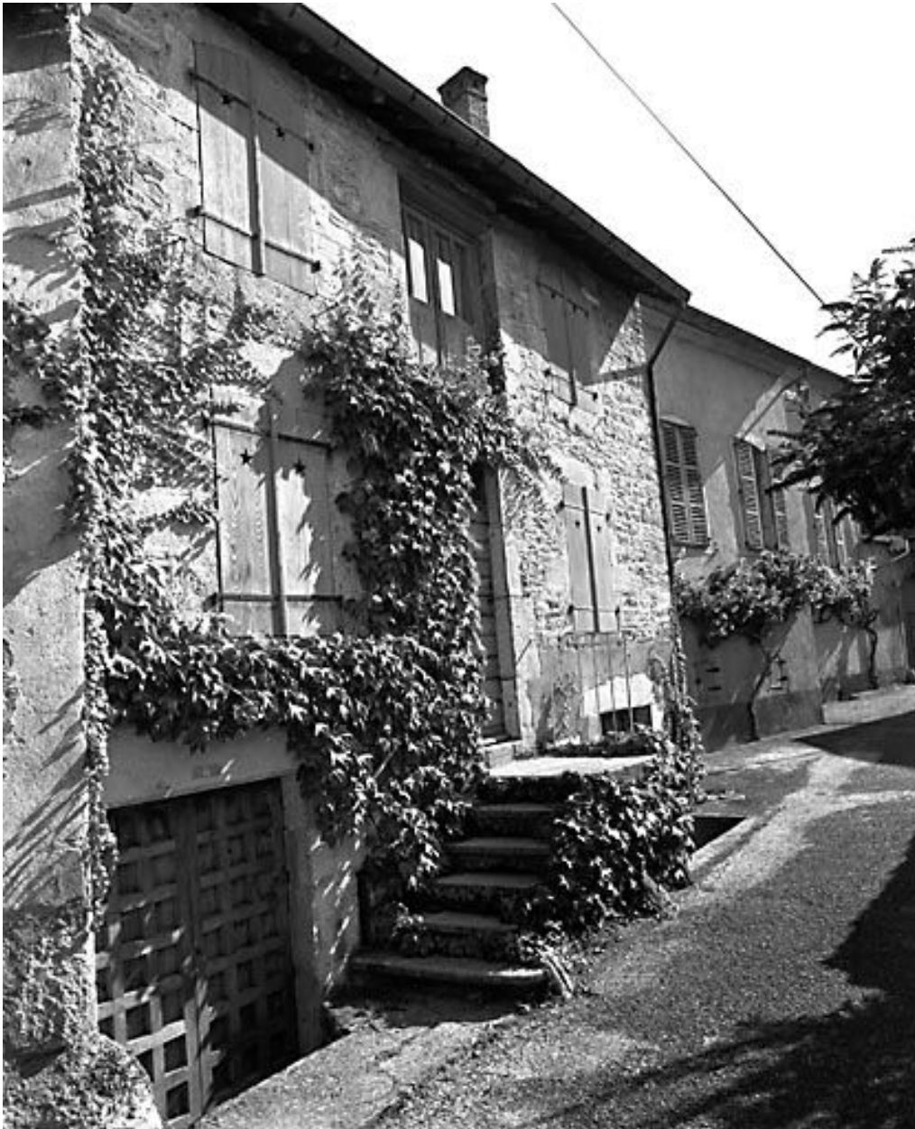
Maison de vigneron située 4 rue du Téméraire.
